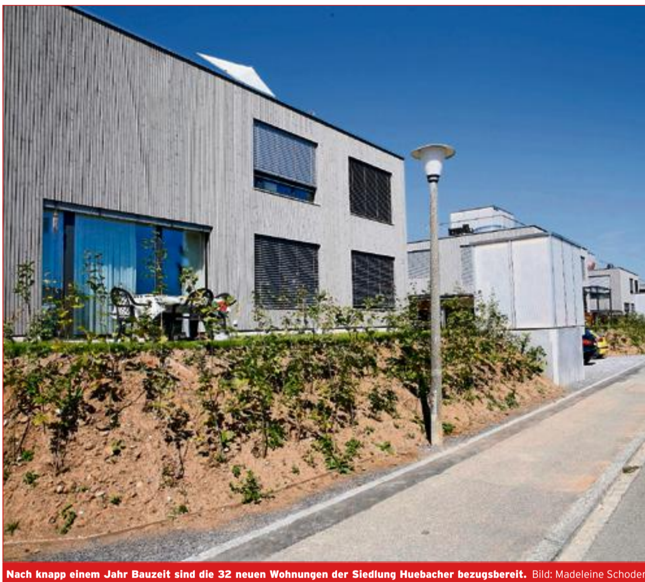
Nach knapp einem Jahr Bauzeit sind die 32 neuen Wohnungen der Siedlung Huebacher bezugsbereit. Bild: Madeleine Schoder
